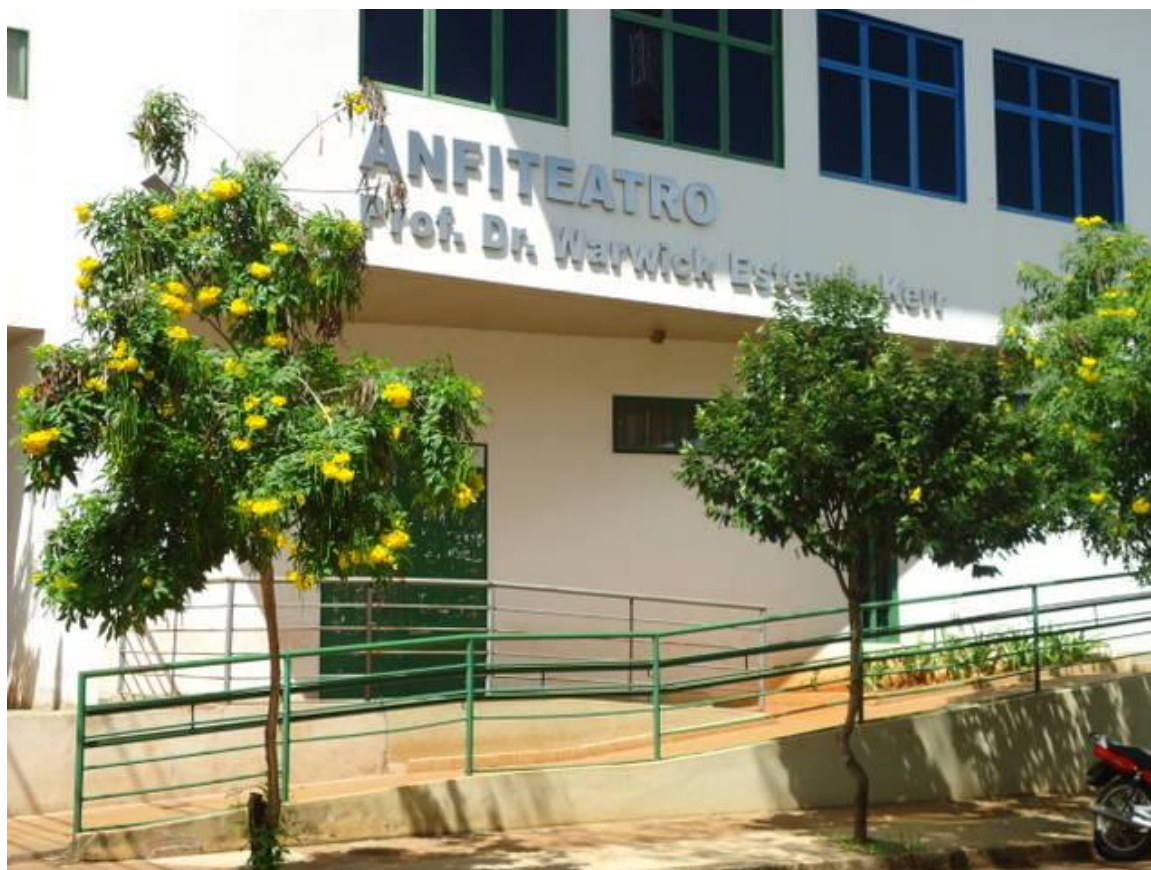
FIGURA 2 – Bloco 4 K, prédio da Escola Técnica de Saúde Fonte: UFU, 2012a.
