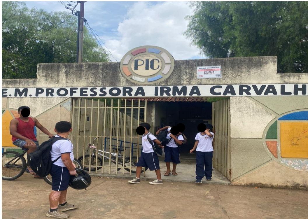
Fotografia1- Fachada da Escola Municipal Irma de Carvalho
