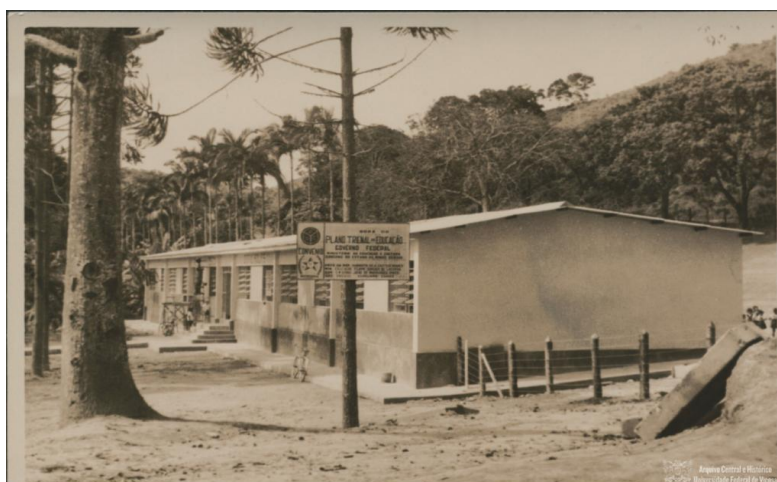
Figura 16 - Prédio do Grupo Escolar Effie Rolfs (vista frontal)
