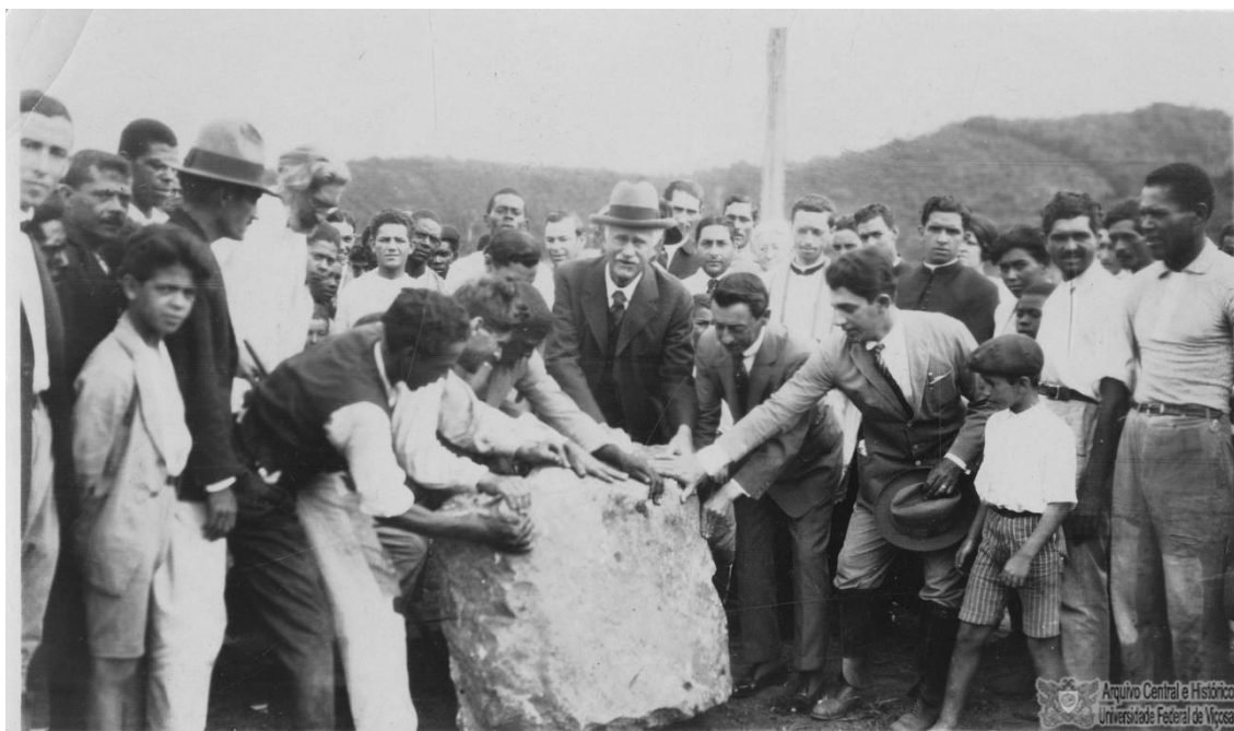
Figura 4 – Lançamento da Pedra Fundamental
