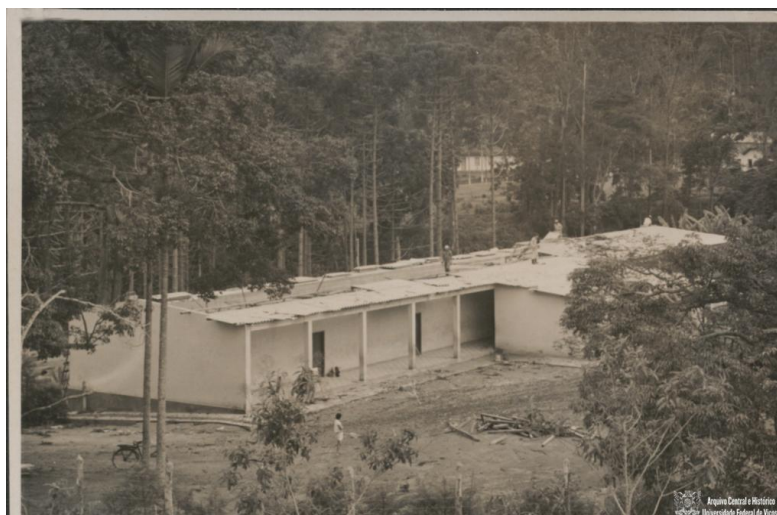
Figura 15: Construção do novo prédio do Grupo Escolar Effie Rolfs
