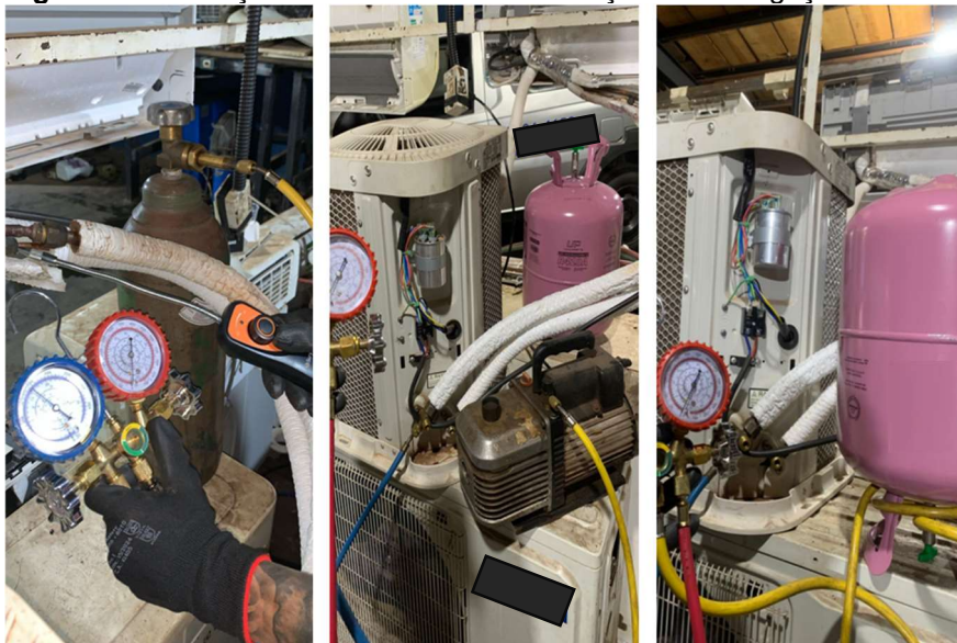
Figura 14 - Correção de vazamento na tubulação de interligação
