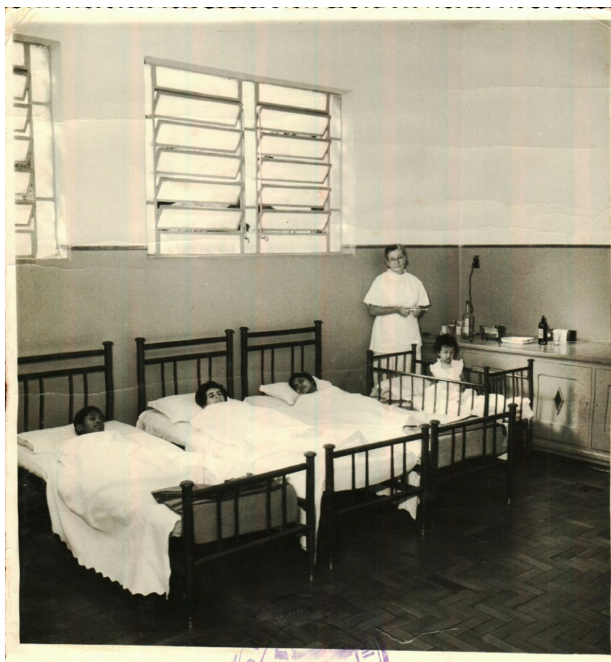
Figura 23 – Acomodações das internas no pavilhão feminino em sua sede própria.
