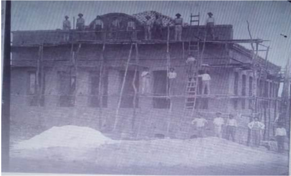
Figura 08- Construção do grupo escolar Afonso Pena
