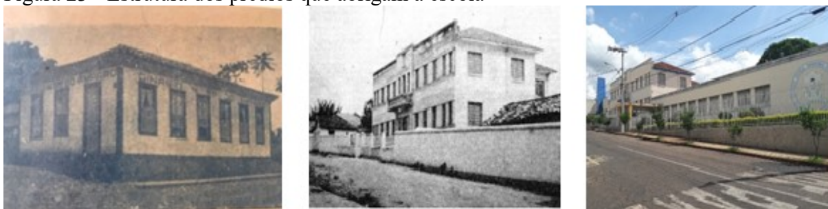
Figura 23 - Estrutura dos prédios que abrigam a escola
