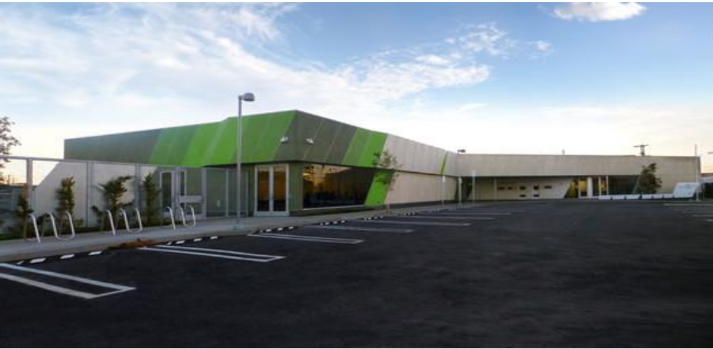
IMAGEM 19: Fachada com estacionamento. Fonte: https://images.adsttc.com/media/images/51f2/8e69/e8e4/4e6d/a300/01bd/medium_jpg/02_sla.jpg?1374850657 . Acesso em 12/03/19
