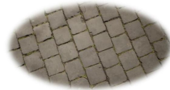
E PARA A PAGINAÇÃO DAS VIAS COLETORAS E ARTERIAL FOI UTILIZADO O PARALELEPÍPEDO POR SER UM MATERIAL RESISTENTE E DE BAIXA MANUTENÇÃO, DANDO UM TOQUE MAIS RÚSTICO AO PROJETO .
