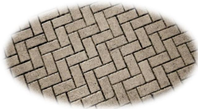
PARA A PAVIMENTAÇÃO DAS VIAS DE CUL-DE-SAC É PROPOSTO O PISO INTERTRAVADO DE CONCRETO. ESTE PISO É O MAIS INDICADO PARA AS VIAS DE ESPAÇOS COMPARTILHADOS ENTRE VEÍCULOS E PEDESTRES POIS AUXILIA NA DIMINUIÇÃO DA VELOCIDADE DOS VEÍCULOS.
