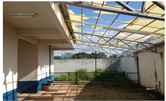
Figura 01. Área externa Centro POP – Fonte: pessoal
