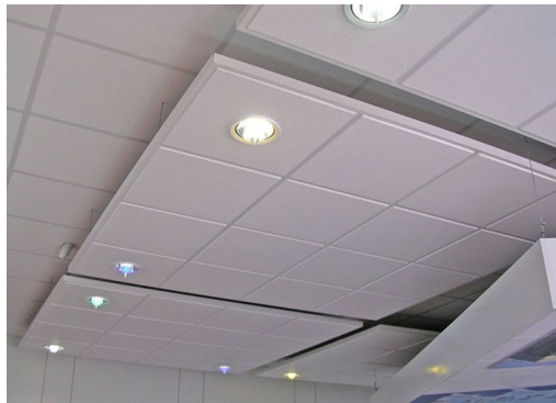
Figura 84 Forro mineral instalado com estrutura metálica e tirantes de arame galvanizado
