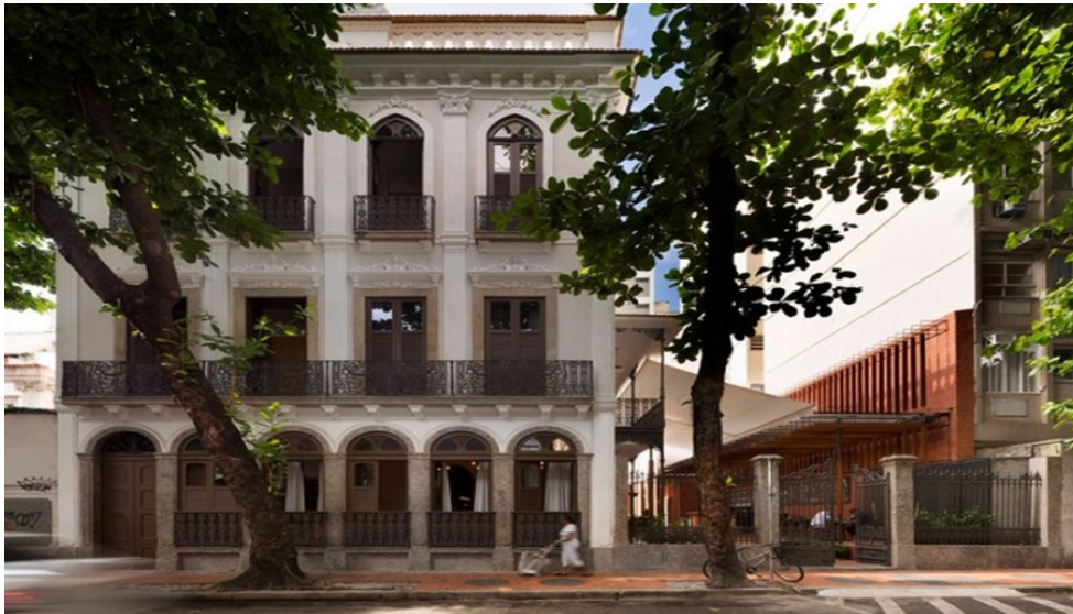
Figura 55: Fachada Hostel Fonte: http://cp.arq.br/projetos/comercial/hostel-villa-25-rio-de-janeiro-br#ficha-tecnica Acesso em: 09/03/2019
