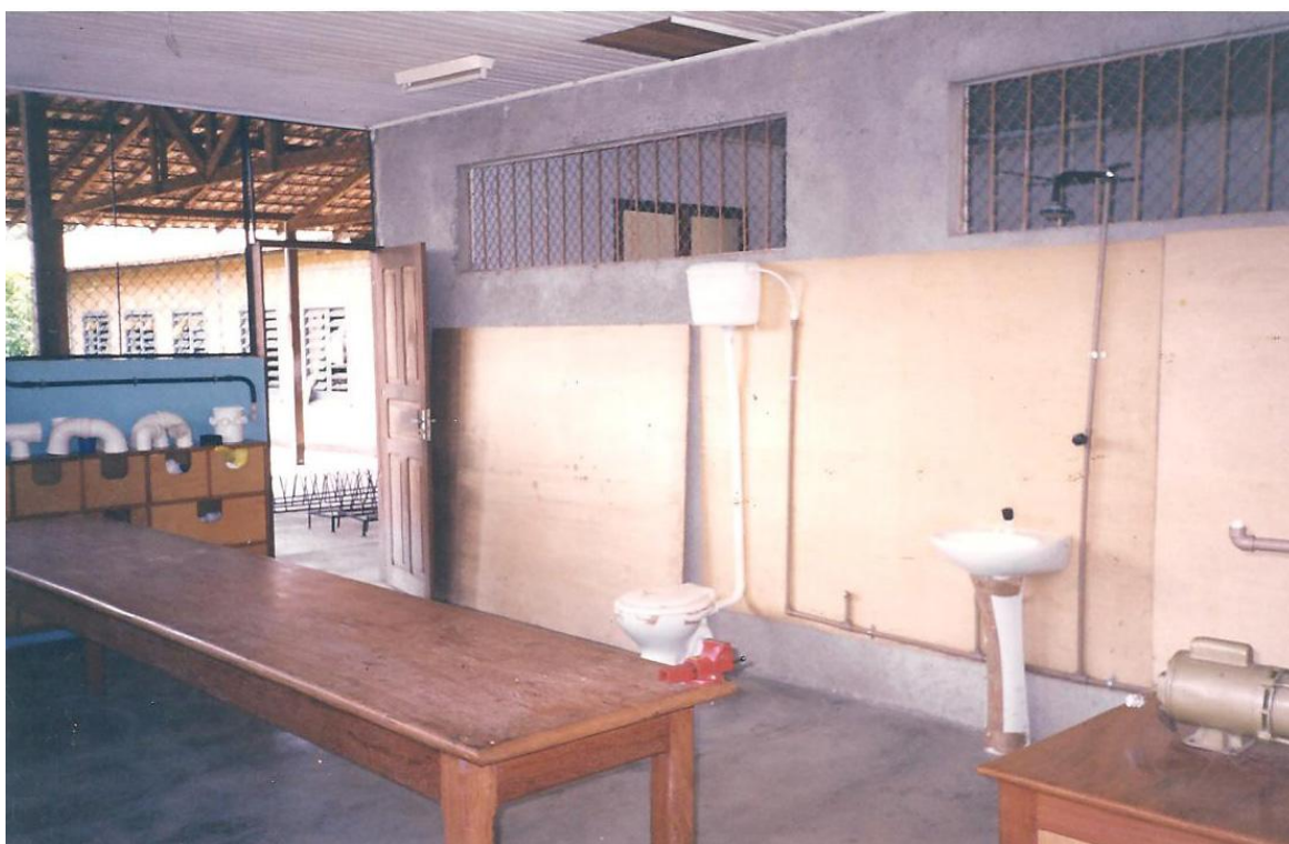
Figura 04 – Estrutura do banheiro e refeitório cedida pelo quartel para atendimento aos alunos (fotografia cedida por Perpétua)
