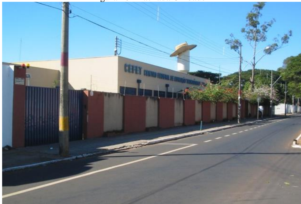
Figura 10 - Fachada Unidade II
