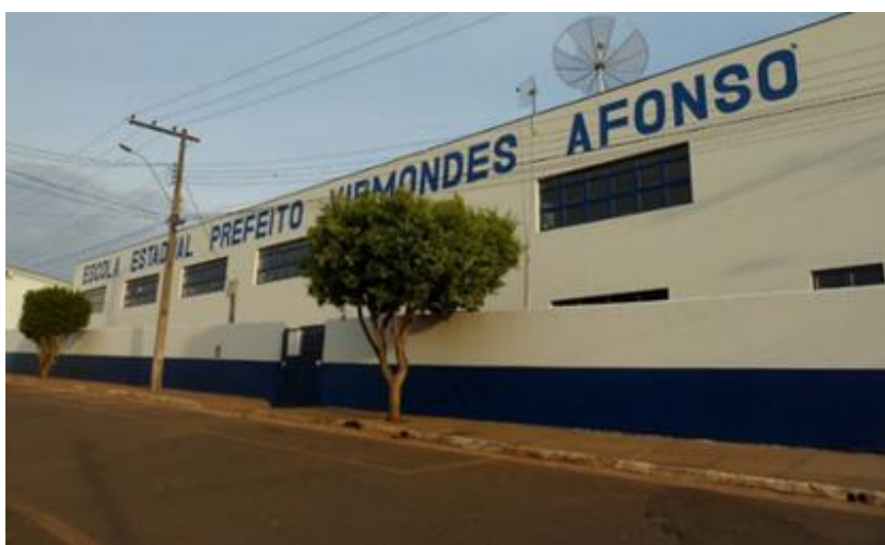
Figura 1: Fachada da Escola Estadual Prefeito Virmondes Afonso
