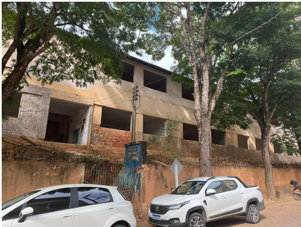
Fotografia 4-Registro do prédio da Escola Estadual Quinca Franco em reforma
