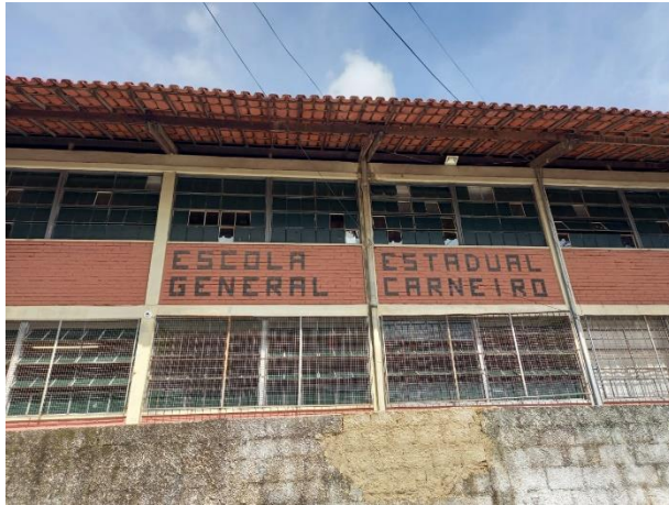
Figura 7 – Fachada da E. E. Gal. Carneiro
