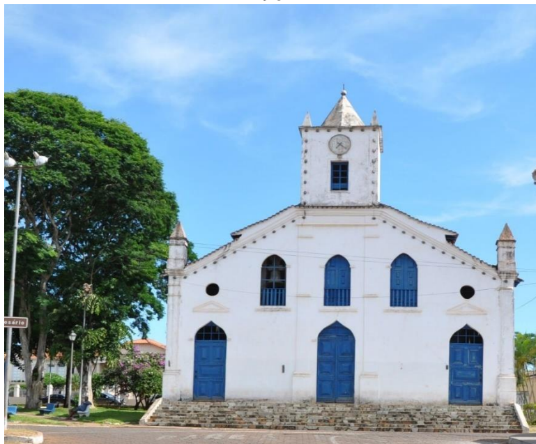
Figura 19 - Igreja Nossa Senhora do Rosário dos Pretos Livres, edificada em 1744 e tombada em 1962
