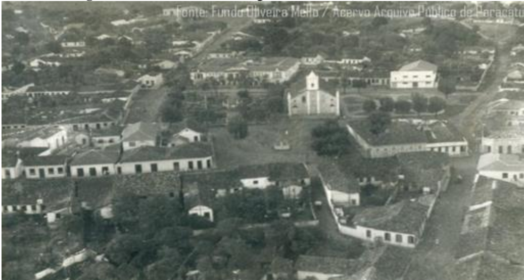
Figura 3 - Vista aérea do Largo do Rosário (década de 1960)
