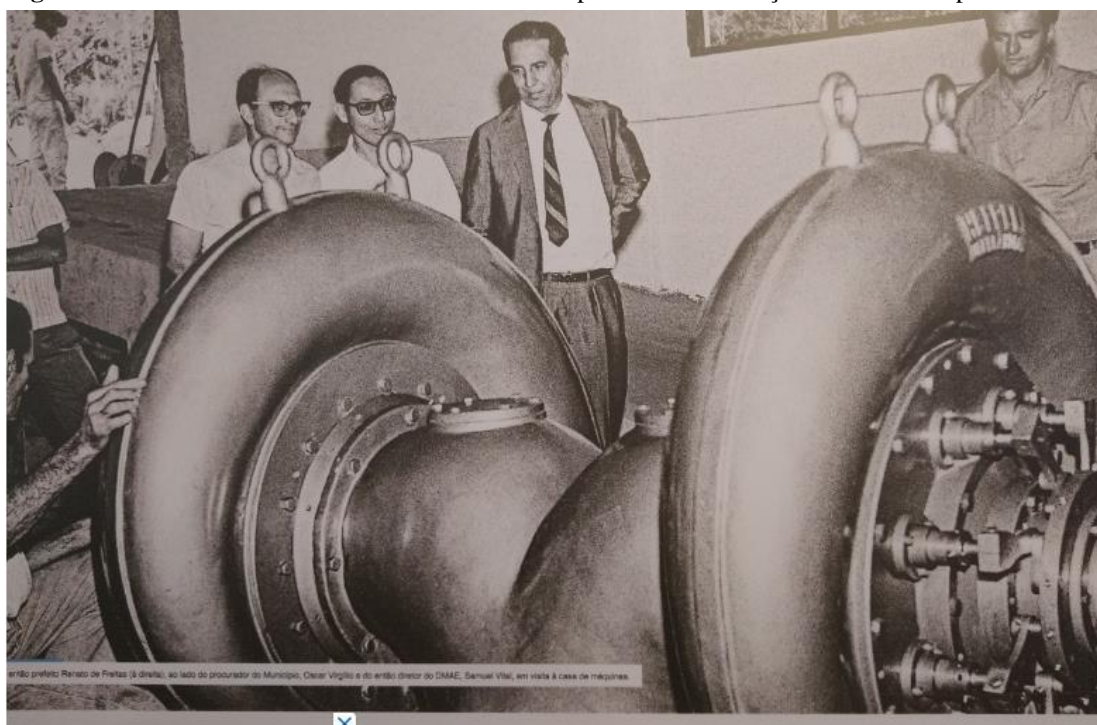
Figura 10 - Foto das turbinas-bombas hidráulicas de paletas na construção da ETA Sucupira
