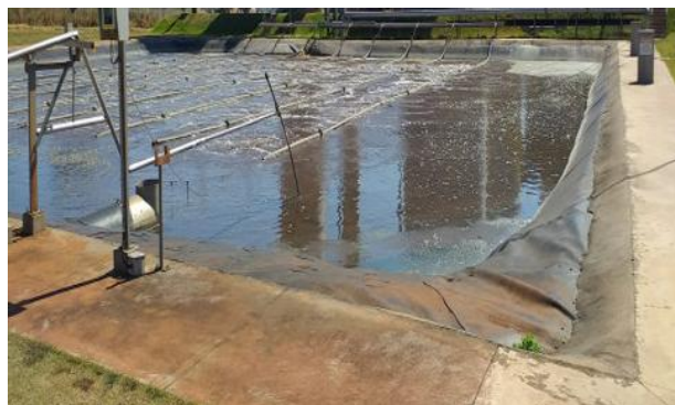
Figura 8 - Lagoa de aeração do efluente industrial.
