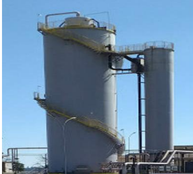
Figura 7 - Reator anaeróbico para produção de biogás.
