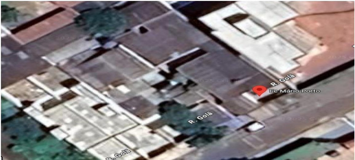
Figura 4 - Escola Estadual Mário Porto - imagem aérea
