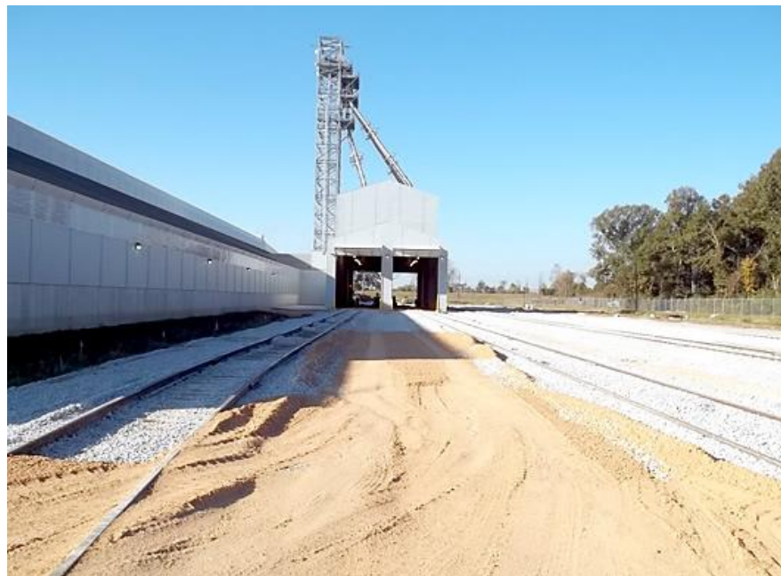
Figura 4.8 – Sistema de descarregamento ferroviário numa unidade de mistura NPK (Yargus Manufacturing, Inc. website, acesso 2017)
