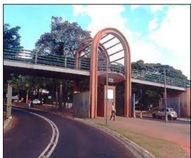
Fig. 6 – Universidade Federal de Uberlândia
