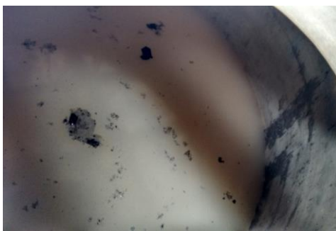
Figura 5: Tanque de armazenamento com resíduos.
