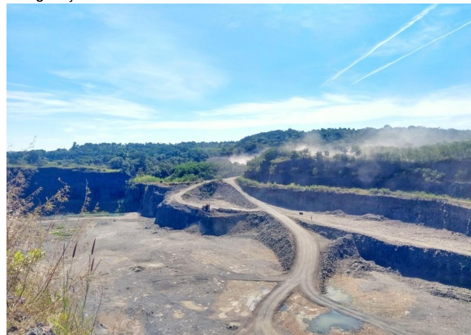
Figura 05, Imagem retirada na área de implantação. Acervo digital do Autor.
