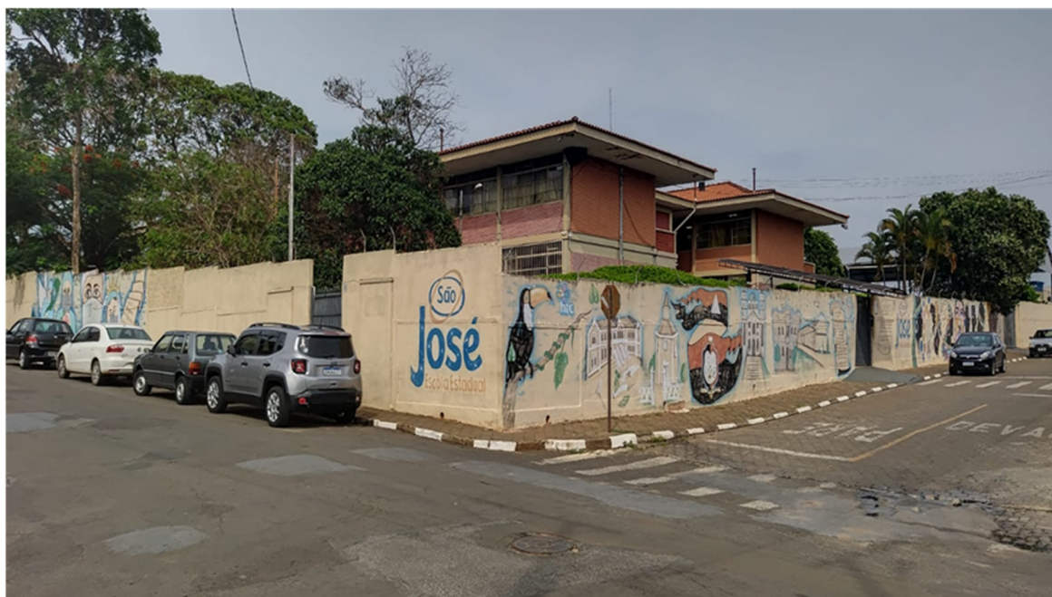
FIGURA 22: Escola Estadual São José, em Passos, Minas Gerais
