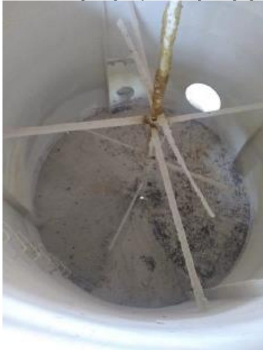
Figura 27 – Resíduos da cal após liquidação do tanque de preparo de leite de cal
