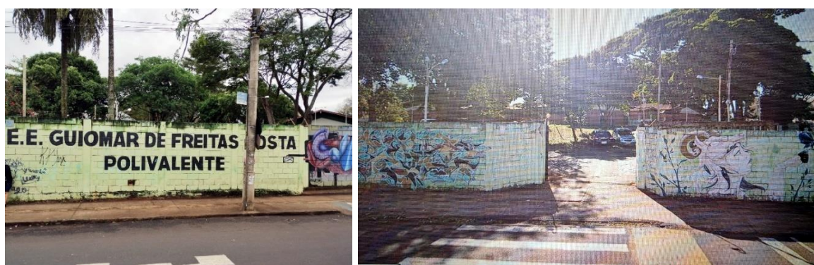
Figura 6 - Muro e entrada da Escola
