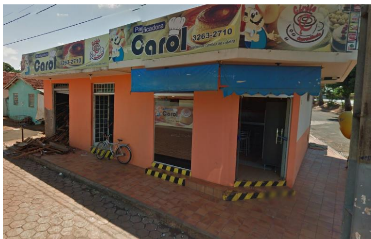
Figura 11 – Fotografia da Faixada da Panificadora
